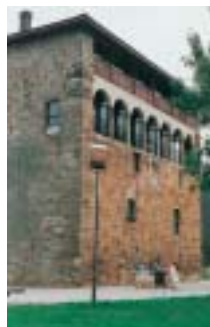
Abadiño. Torre de Muntzaraz. El edificio se divide en dos partes claramente diferenciadas. De un lado la torre original, gótica, con muros de sillería que alcanzan los 2,70 metros de grosor, clara expresión de las necesidades defensivas existentes al tiempo de su construcción. La parte superior, resultado de reformas posteriores, contrasta poderosamente por su aspecto, mucho más airoso gracias a su "loggia" o solana de gusto renacentista italiano, con arcos de medio punto sobre columnas toscanas de basa ática. Sobre ella se apoya un tejado a cuatro vertientes. El escudo sobre el dintel de la entrada es de una época posterior a la torre primitiva. Coincide, posiblemente, con la reforma de los pisos superiores. La puerta conserva una aldaba gótica.
