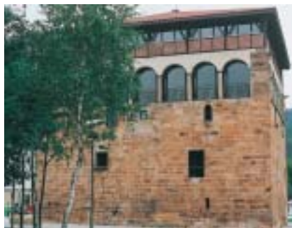
Abadiño. Torre de Muntzaraz. El edificio se divide en dos partes claramente diferenciadas. De un lado la torre original, gótica, con muros de sillería que alcanzan los 2,70 metros de grosor, clara expresión de las necesidades defensivas existentes al tiempo de su construcción. La parte superior, resultado de reformas posteriores, contrasta poderosamente por su aspecto, mucho más airoso gracias a su "loggia" o solana de gusto renacentista italiano, con arcos de medio punto sobre columnas toscanas de basa ática. Sobre ella se apoya un tejado a cuatro vertientes. El escudo sobre el dintel de la entrada es de una época posterior a la torre primitiva. Coincide, posiblemente, con la reforma de los pisos superiores. La puerta conserva una aldaba gótica.
